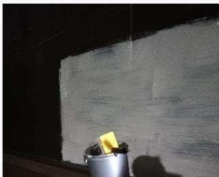
Aplicación de EZY-NET® con cepillo de pintura de bloque o sin aire en la superficie contaminada con hollín (causado por el fuego).
