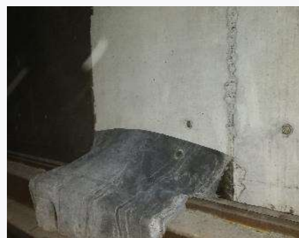
Pelad la película EZY-NET® después de que se haya secado, lo que resulta
